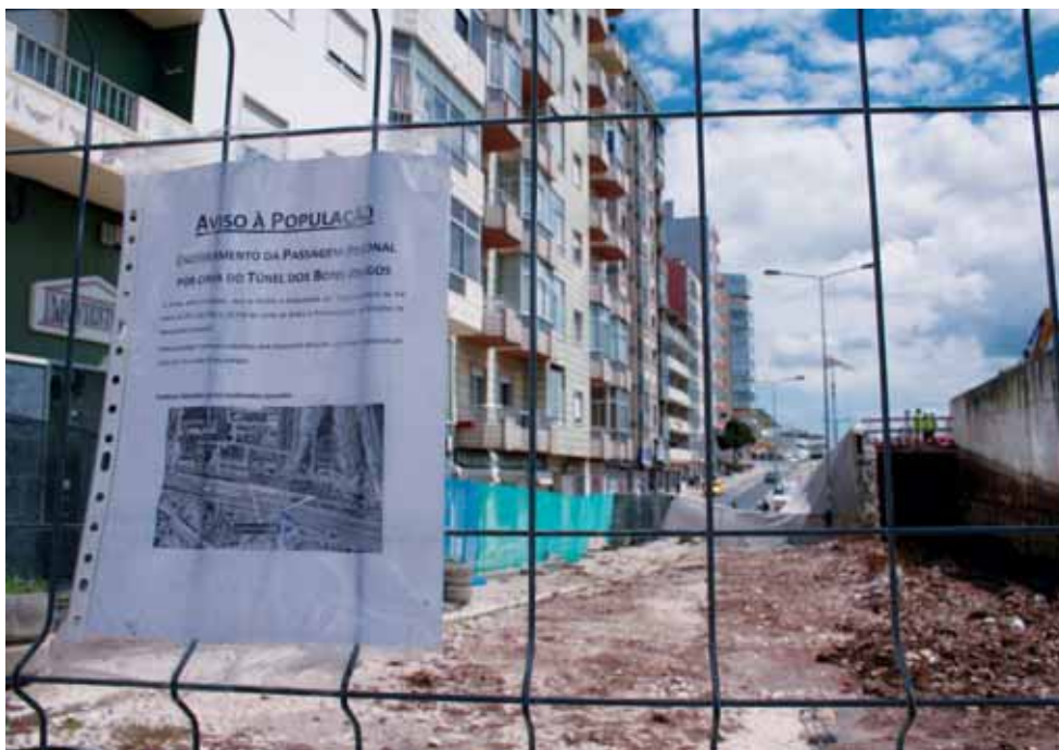
Obras da nova estação da Refer implicaram a demolição da antiga passagem pedonal sobre o túnel da Avenida dos Bons Amigos
