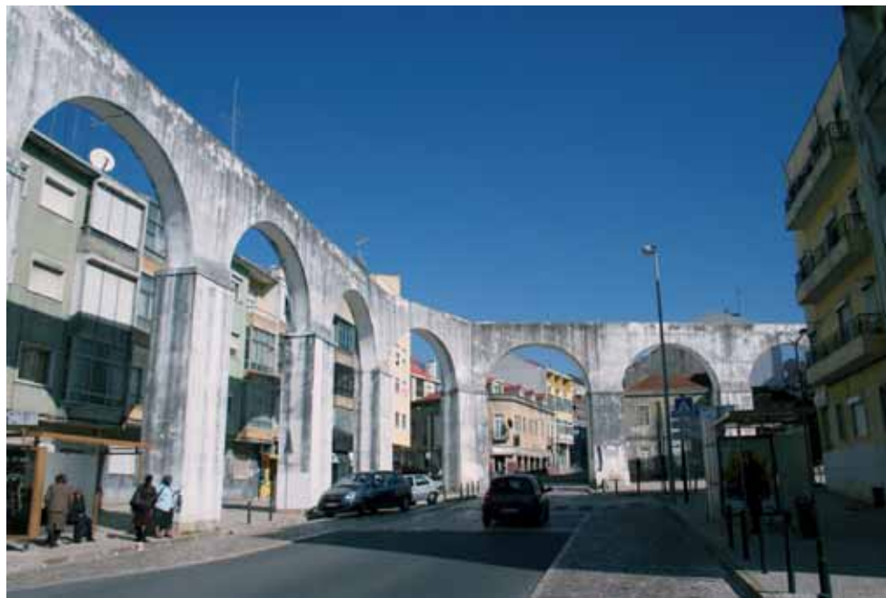
Comerciantes de Casal de Cambra, Belas e até Queluz queixam-se da quebra no negócio
